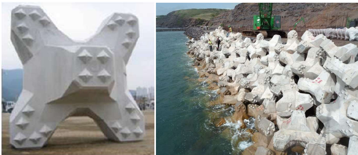
Figure 5 : Présentation d'un bloc ACCROPODE™ et illustration de leur mise en oeuvre au niveau d'un ouvrage (source : www.concretelayer.com )
